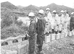
築堤工事現場を見学
